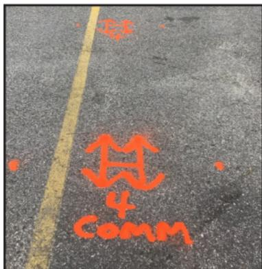
Dos flechas se conectan con una línea perpendicular, para formar una "H". Número de cables indicado, si se conoce.
