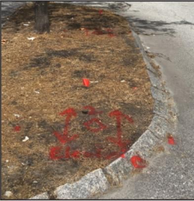
Dos flechas unidas con forma de rombo. Principalmente en zonas céntricas, a menudo revestidos de hormigón o madera. Para conductos apilados múltiples, se indicará el número, si se conoce.
